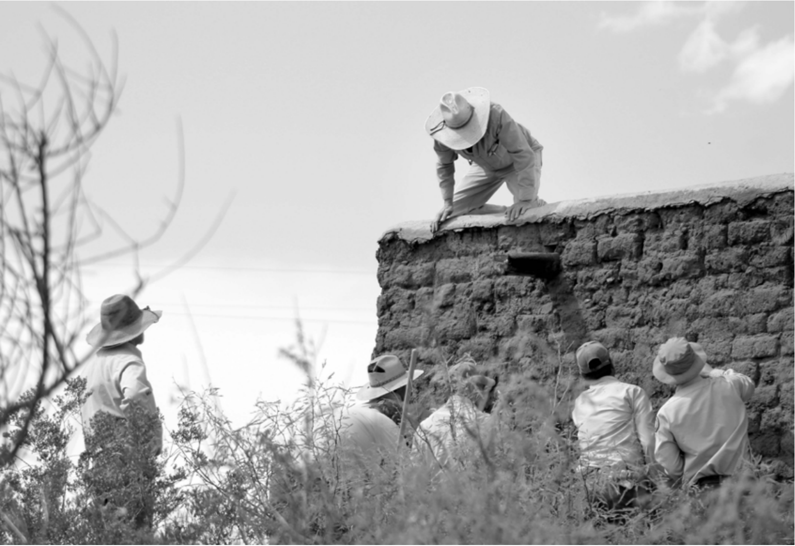
David Keller directs a plastering project on the Burgess family mausoleum at Fort Leaton. David Keller dirige un proyecto de enyesado en el mausoleo de la familia Burgess en Fort Leaton.
