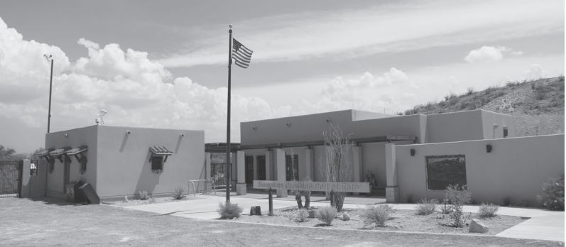
Photo Courtesy / Foto cortesía Wikimedia Commons, Bic, CC BY-SA 3.0 The Boquillas port of entry. / El puerto de entrada de Boquillas.
