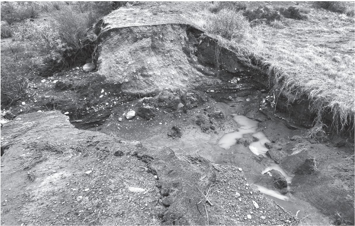
Una presa en un estanque de retención cerca de una casa en Redford permanece sin reparar después de que una inundación rompiera sus muros.
