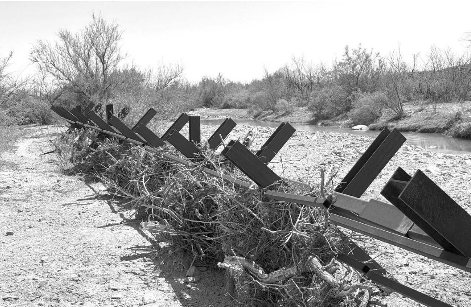
Una barrera vehicular junto a la carretera 170, en el condado de Presidio. Si bien la Patrulla Fronteriza ha utilizado habitualmente este modelo de barrera en el pasado, se desconoce qué tipos de barreras se están considerando para el proyecto del muro fronterizo.
