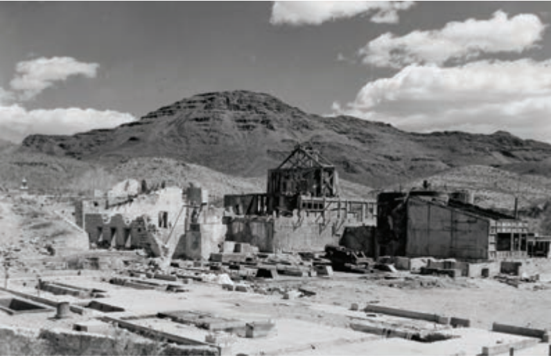
Aunque quedan ruinas en el pueblo fantasma de Shafter, la minería real ocurría al este de la Carretera 67.
