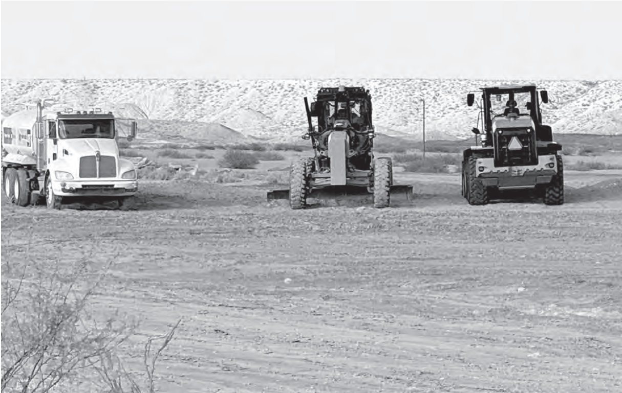
El sitio de operaciones que se está habilitando para Fisher Industries en Presidio, sobre la carretera FM 170, cuenta con equipo y remolques de oficina alquilados.
